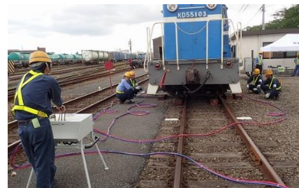
車両脱線復旧訓練
