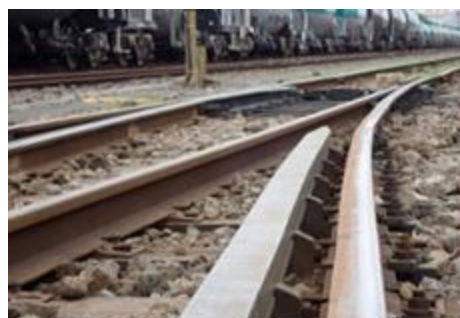
脱線防止ガードレール設置
