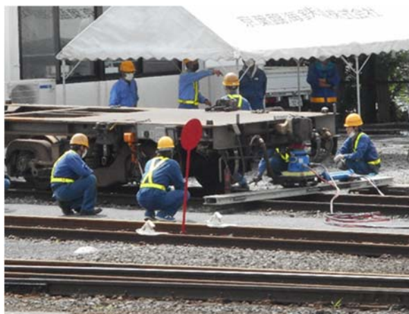
車両脱線復旧訓練
