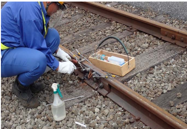
線路復旧訓練
